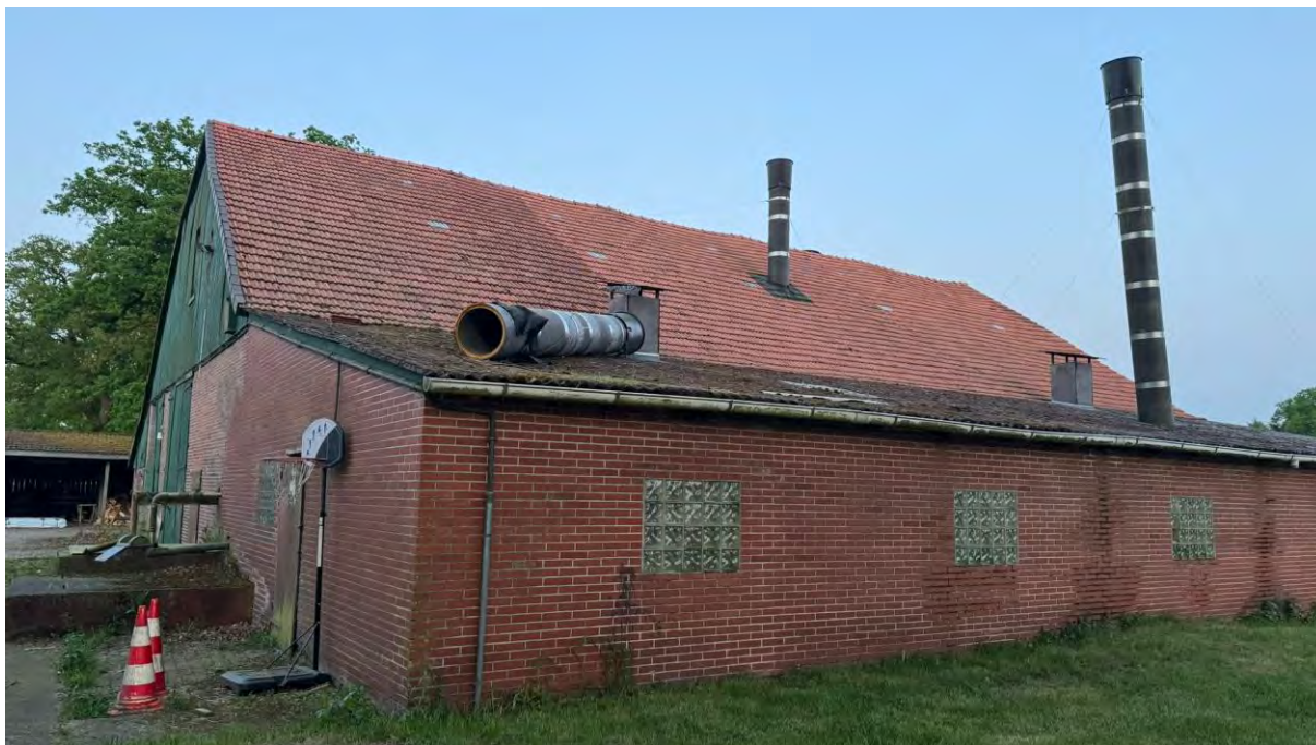
Abb. 2: Ehemaliger Stall. Blick von Westen. Aufnahme: 03.05.2024
