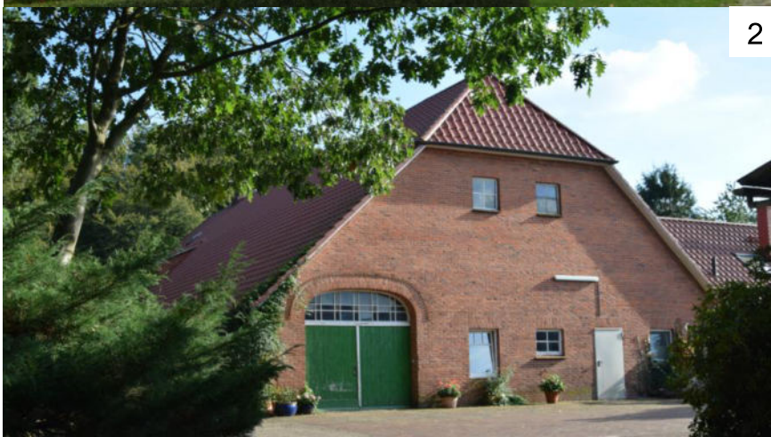
Abbildung 20. Nds. Hallenhaus in der Zweiständer-Bauweise (1) und Gulfhaus (2) Quelle: NWP Planungsgesellschaft mbH, Gemeinde Hatten
