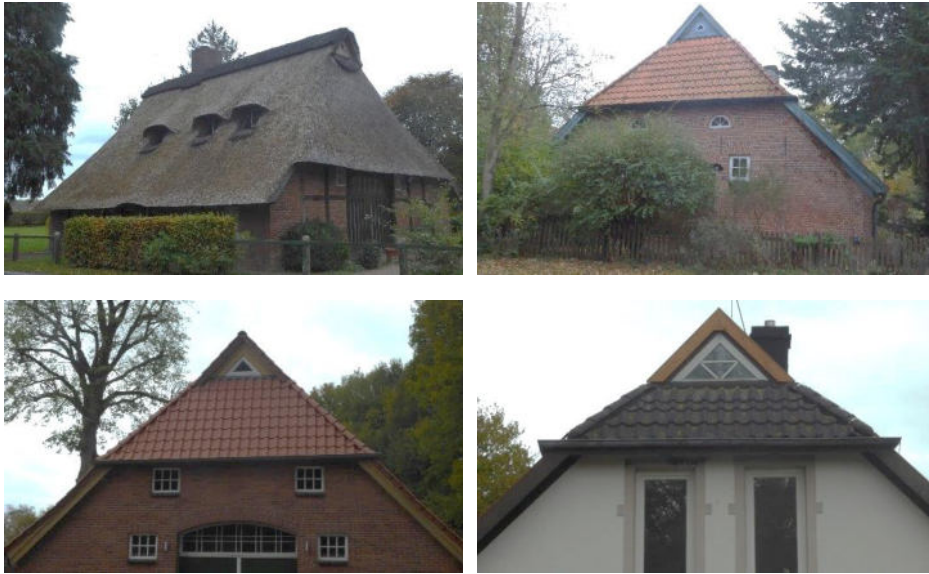
Abbildung 50: Dachformen in der Dorfregion Quelle: NWP Planungsgesellschaft mbH
