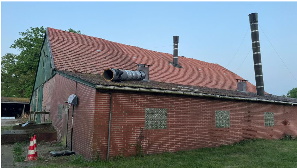
Abb. 2: Ehemaliger Stall. Blick von Westen. Aufnahme: 03.05.2024
