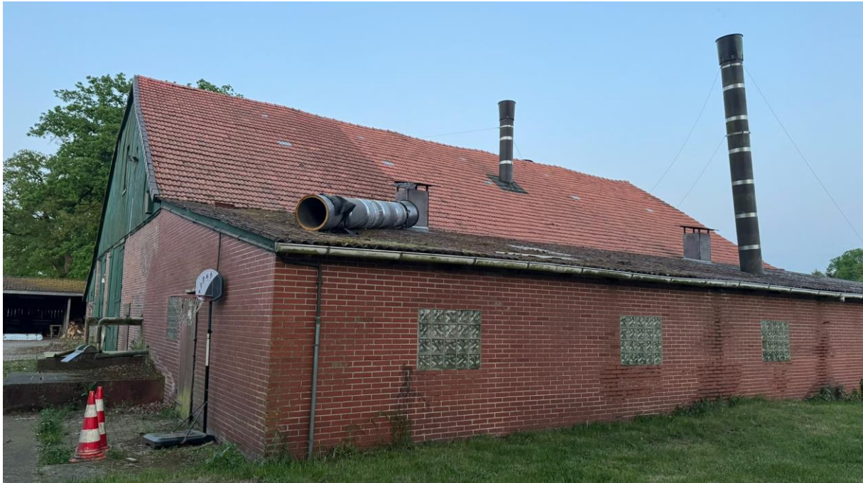
Abb. 2: Ehemaliger Stall. Blick von Westen. Aufnahme: 03.05.2024
