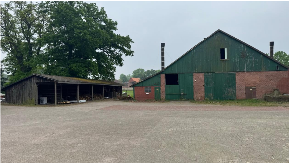
Abb. 5: Ehemaliger Stall und Holzschuppen. Beide Gebäude sollen rückgebaut werden. Blick von Norden. Aufnahme: 03.05.2024
